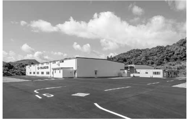
平成30年竣工の大分・宇佐工場
