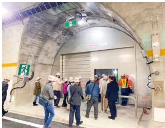
(上)羽根トンネル内、上下線の間にある避難通路を見学 (下)菩提高架橋では舗装工事の仕上げが行われていた
